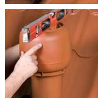
10. Asenna päälle tuleva putki paikoilleen ja tarkista vesivaa'alla, että putki tulee pystysuoraan.
