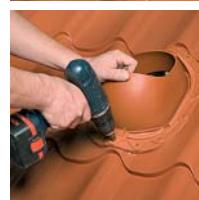
8. Aseta läpivienti paikalleen ja kiinnitä ruuvit ensin ylä- ja alareunoihin.
