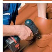
9. Kiinnitä seuraavaksi ruuvit molempien ylä- ja alasivuihin käyttäen opuna kiinnitysklipsejä (4 kpl). Tämän jälkeen ruuvaan muut ruuvit kiinni. Kiinnitysklipsejä on lisäksi 2 kpl varalla, jos ruuvi "korkkaa".
